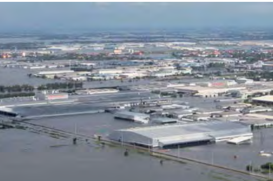
Overstroming van de Honda fabrieken in Rojana Industrial Estate nabij Bangkok. Deze lagen tot maanden na de overstroming stil.
